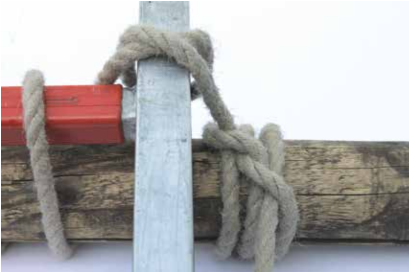
Abb. 24: Kopfpunktsicherung Schritt 5
