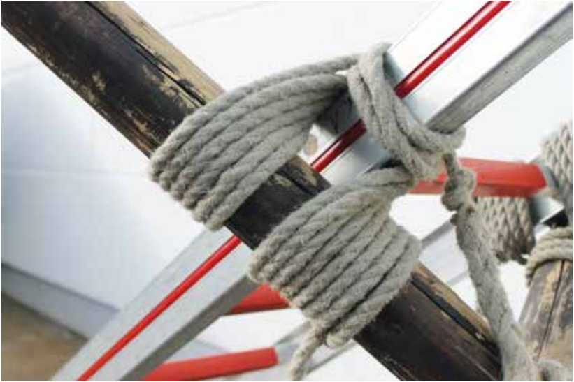
Abb. 32: Verbindung mittels Bockschnürlage
